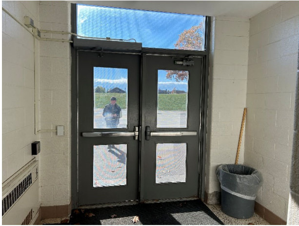
Door # Stair B (Set 6)
